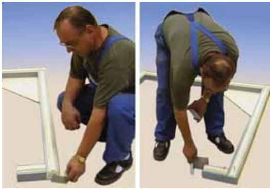
zdz. 5 Instalacja kontowników zdz. 6 L-wspornik
